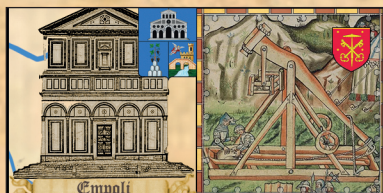
Le forze fiorentine assediano Empoli. Il trabucco è all'opera per cercare di sfondare le mura azzurre.
